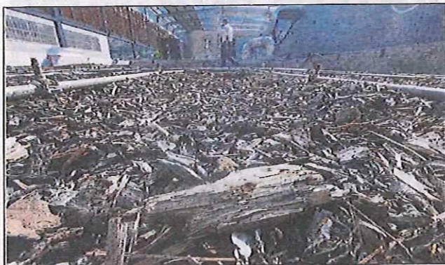
Les biofiltres rénovés reçoivent et filtrent l'air déjà désodorisé dans la tour de lavage (au fond à gauche). (Photos Sébastien Botella)
