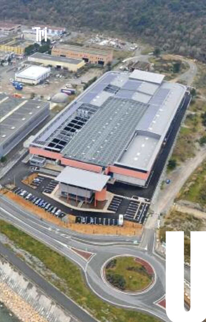
Le CVO du Broc, un équipement à la pointe des technologies les plus récentes.
