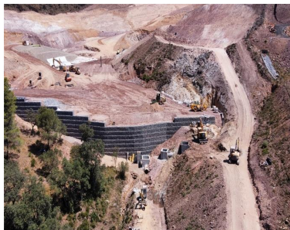
Figure 12 : Mur en gabions soutenant les bassins pluviaux
