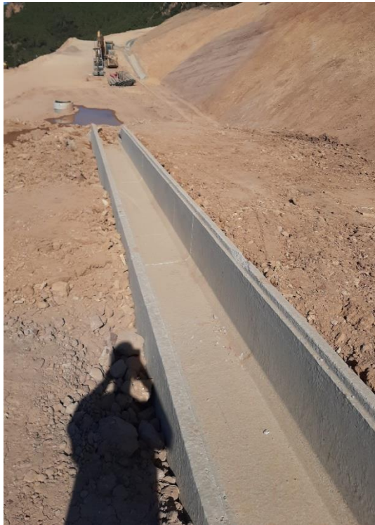
Figure 10 : Caniveaux coulés en place
