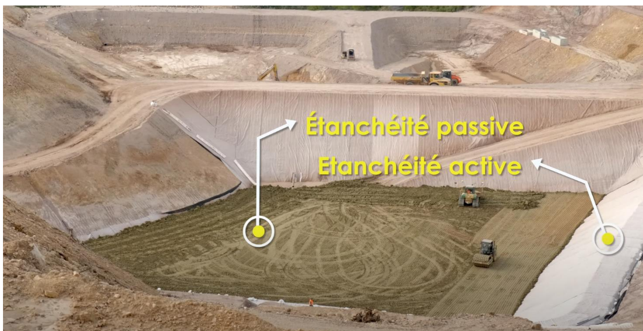
Figure 9 : Mise en forme du casier
