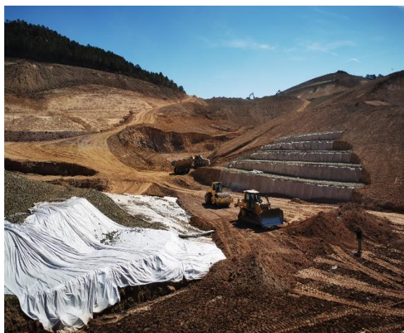
Figure 12 : Mur en gabions soutenant les bassins pluviaux
