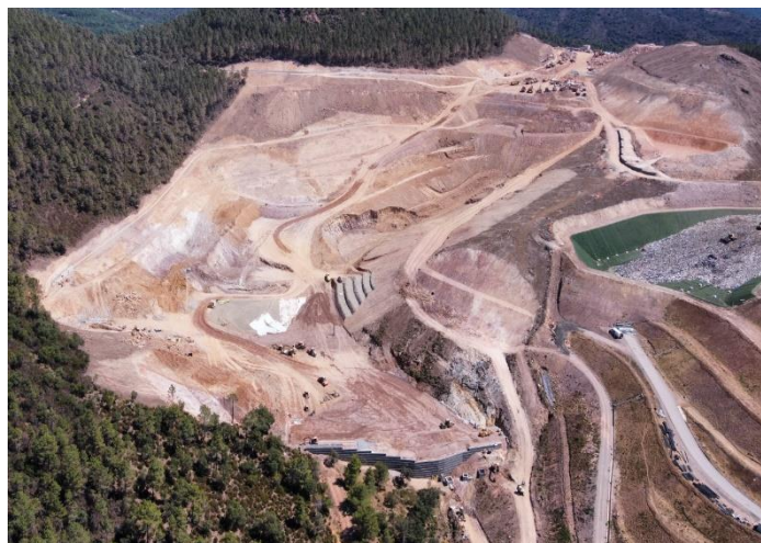
Figure 9 : Mise en forme du casier
