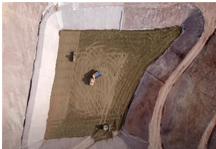
Figure 9 : Mise en forme du casier
