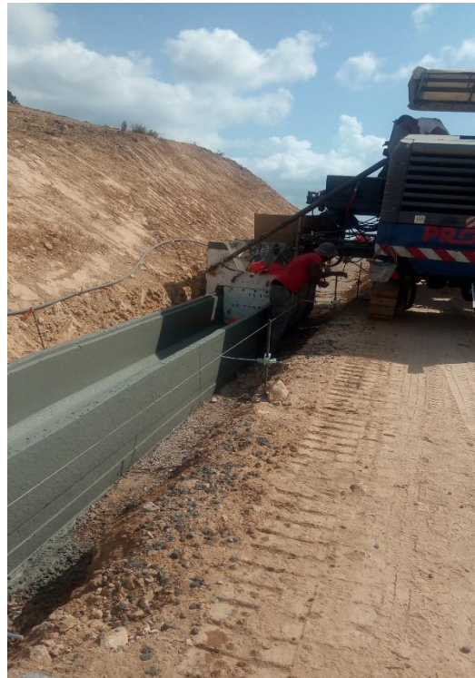
Figure 10 : Caniveaux coulés en place
